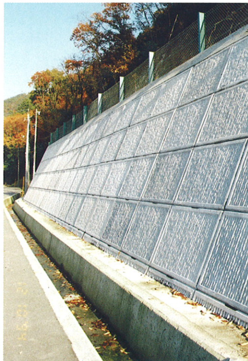
法留 もたれ式擁壁タイプ 施工例▼
