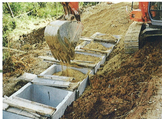
▲中詰材に現地発生土利用
