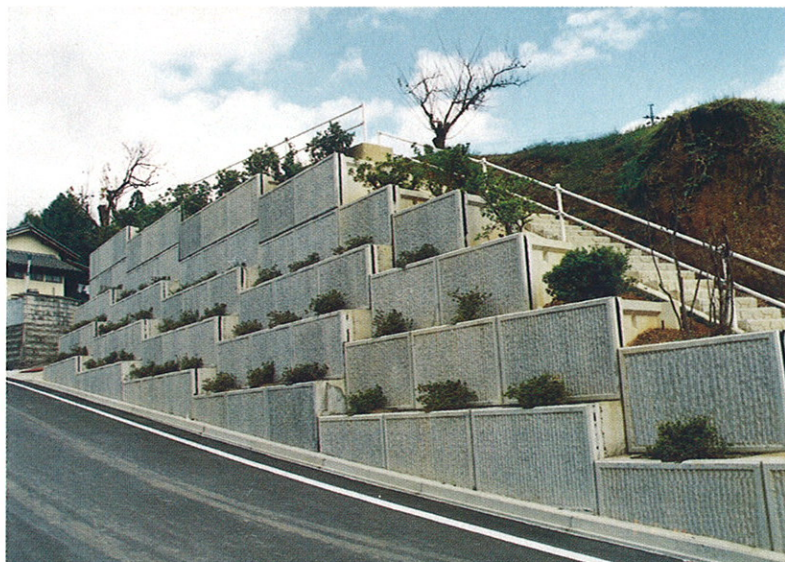
▲法留 階段積 緑化タイプ 施工例
