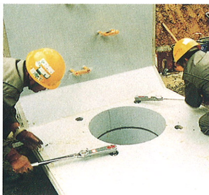
底設ビット緊結工
