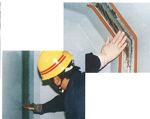
底設ビット緊結工
