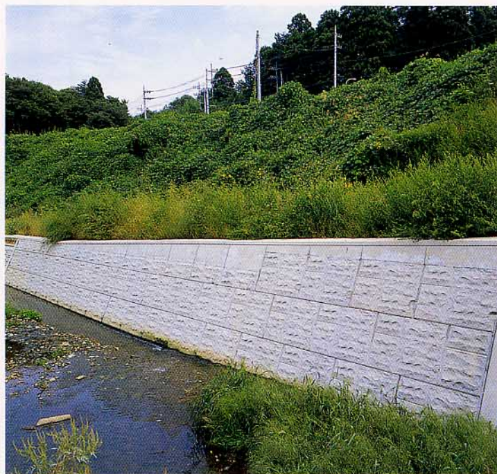
茨城県・準用河川狭間川河川改修その2工事
