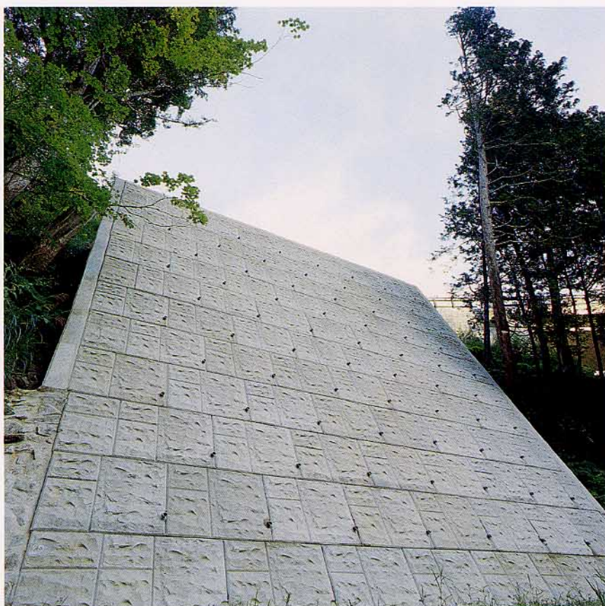
青森県・恐山大畑線道路改良工事
