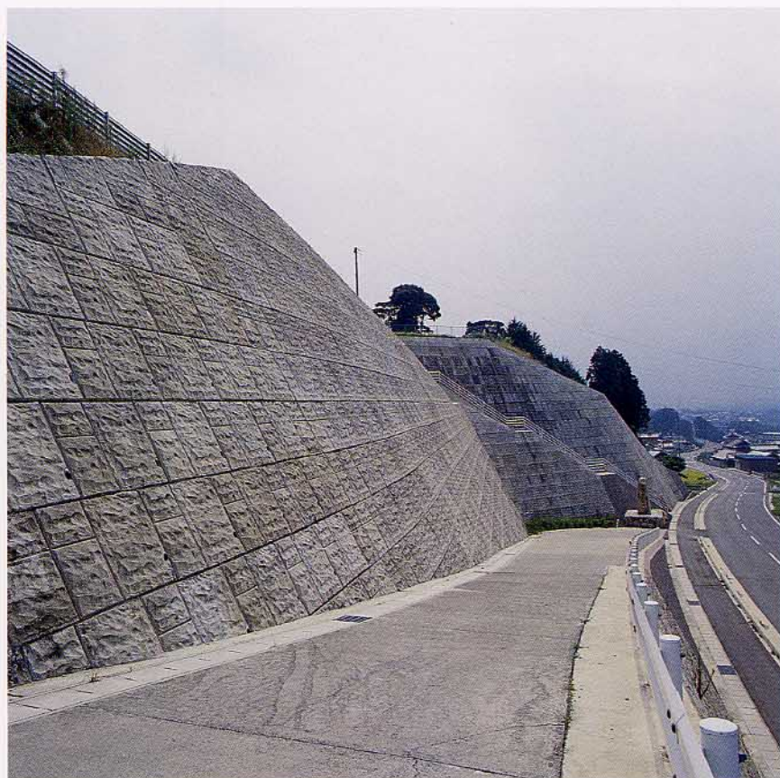
三重県・亀山市亀山石水溪線地方道路整備工事
