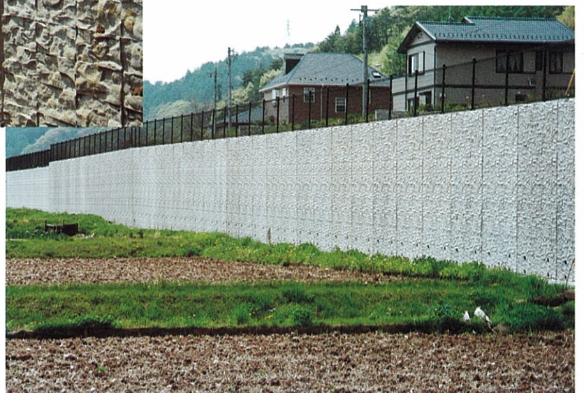
村営城山団地造成工事 八千穂村 城山 (八千穂村役場)
