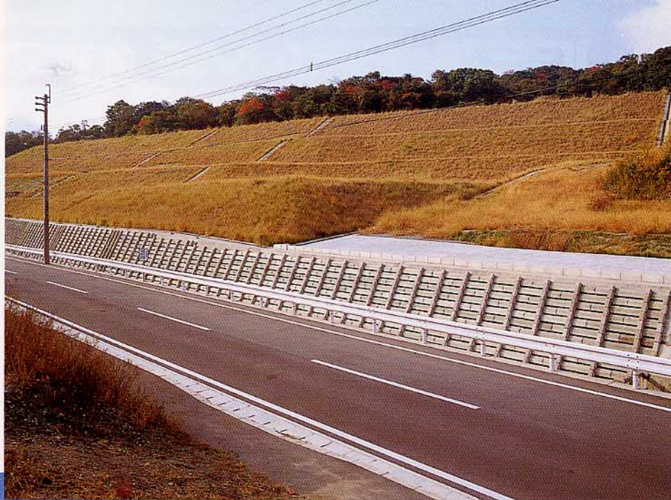
福岡県 ぼた山防災工事
