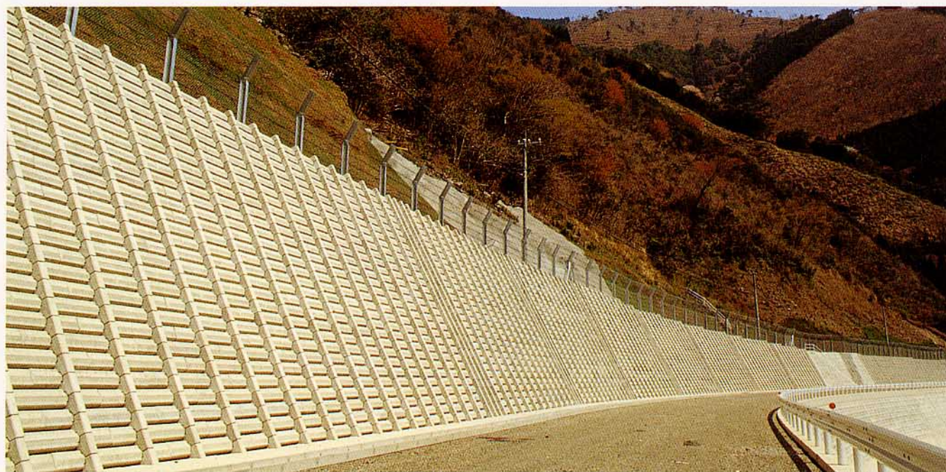
熊本県 付替村道金川地区擁壁工事
