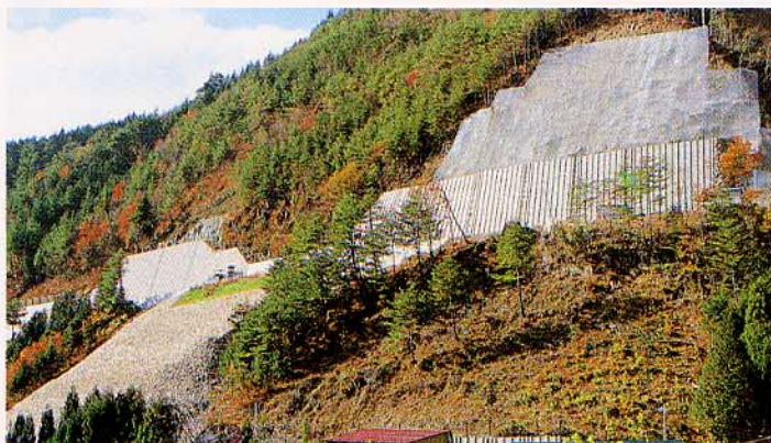
岐阜県 阿多岐ダム付替道路工事
