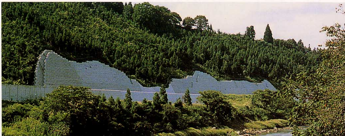
長野県 国道117号道路改良工事
