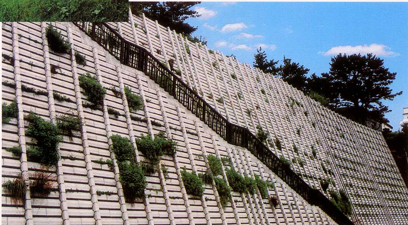
愛知県 緊急急傾斜地崩壊対策工事
