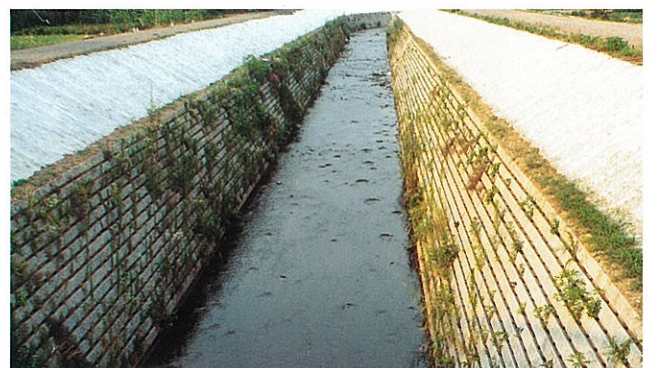
●発注：上田建設事業所 ●工事名：平成12年度国補河川局部改良工事 ●場所：上田市大屋（瀬沢川）
