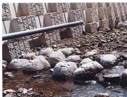
河川改修工事 瀬沢川 上田市 芳田 (上田建設事務所)
