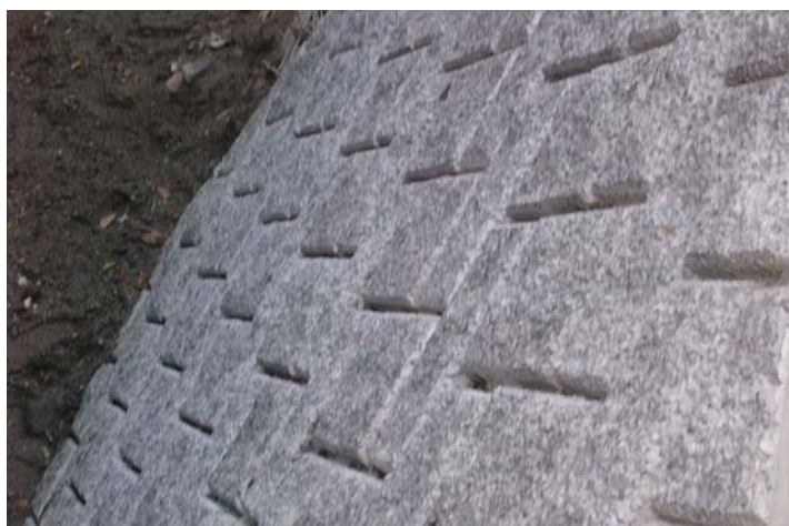
深い目地構造（擁壁天端より）
