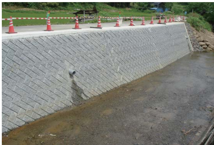
18 災 河川災害復旧工事 【信州新町 中奈良尾 柳久保川】
