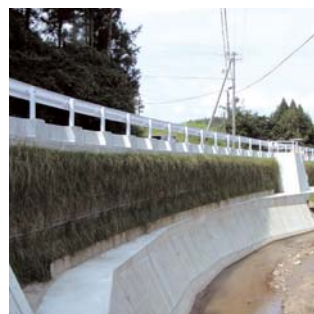
ジオテキスタイル補強土壁
