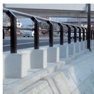
大型ブロック積擁壁
