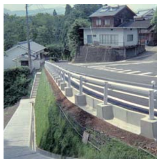
ジオテキスタイル補強土壁
