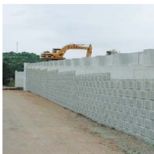
補強土壁 (ジオグリッド)
