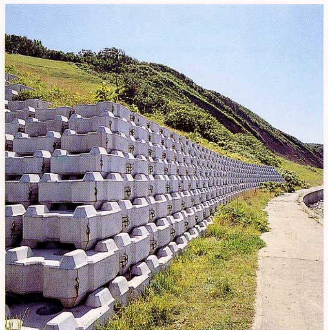
北海道 網走公園線災害復旧工事
