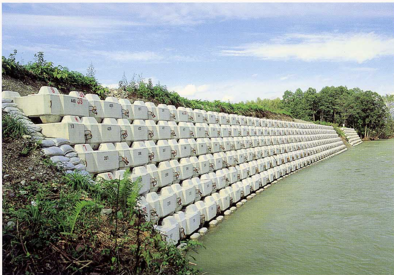
北海道 猿別川災害復旧工事
