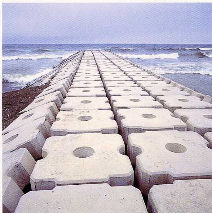
青森県 三沢海岸侵食対策工事
