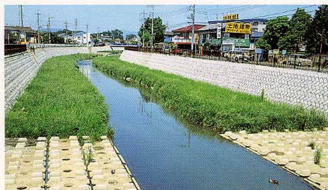
東京都 川口川河川改良工事
