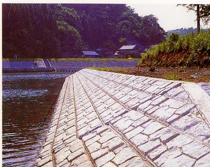
大分県 玉来川河川改修工事
