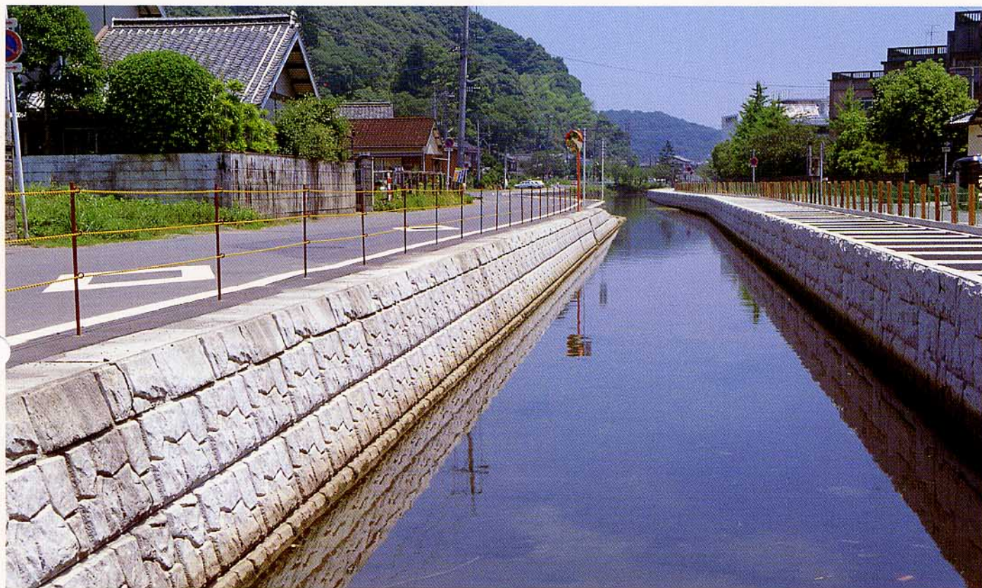
大分県 臼坪川下水道整備工事
