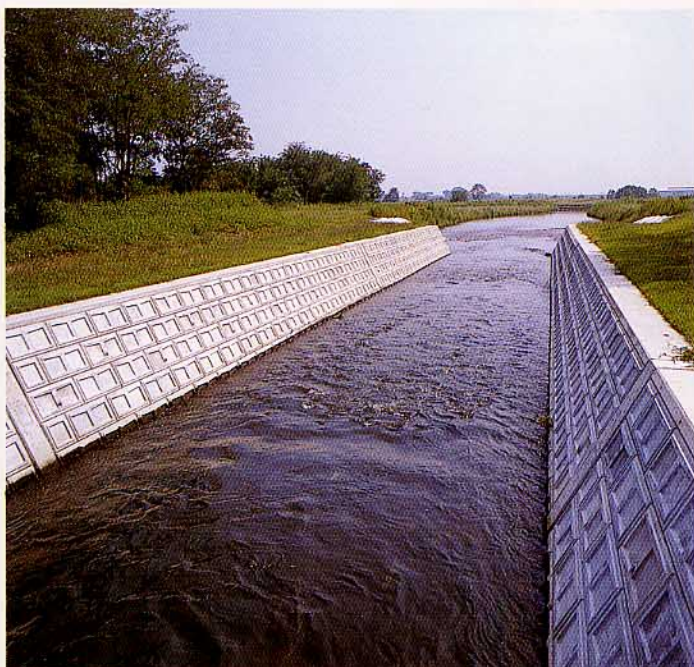
群馬県 滝川災害復旧工事
