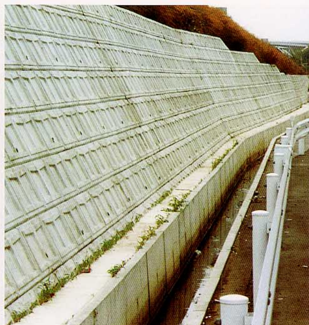
千葉県 東関東自動車道大曾根工事
