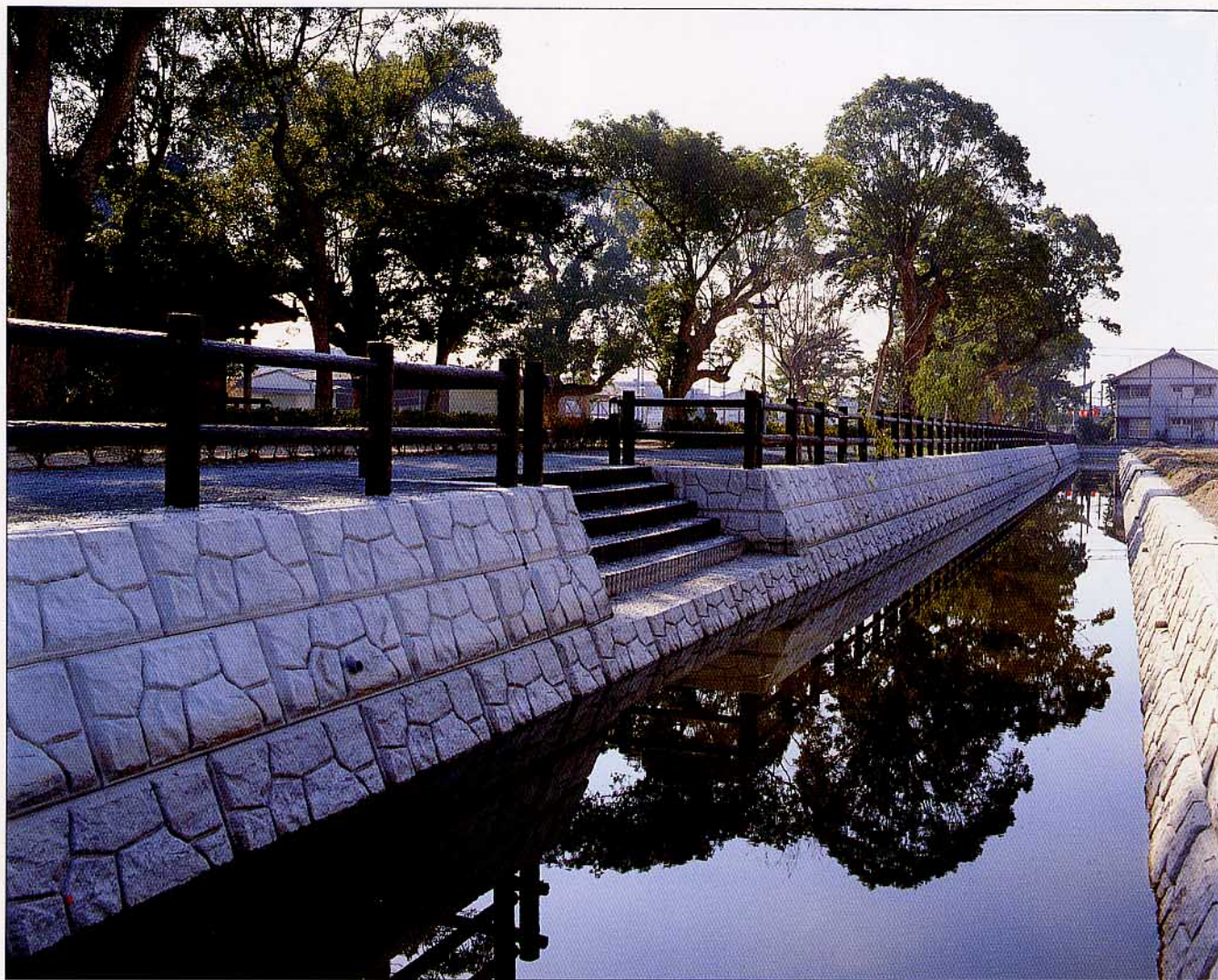
福岡県 農業排水施設工事
