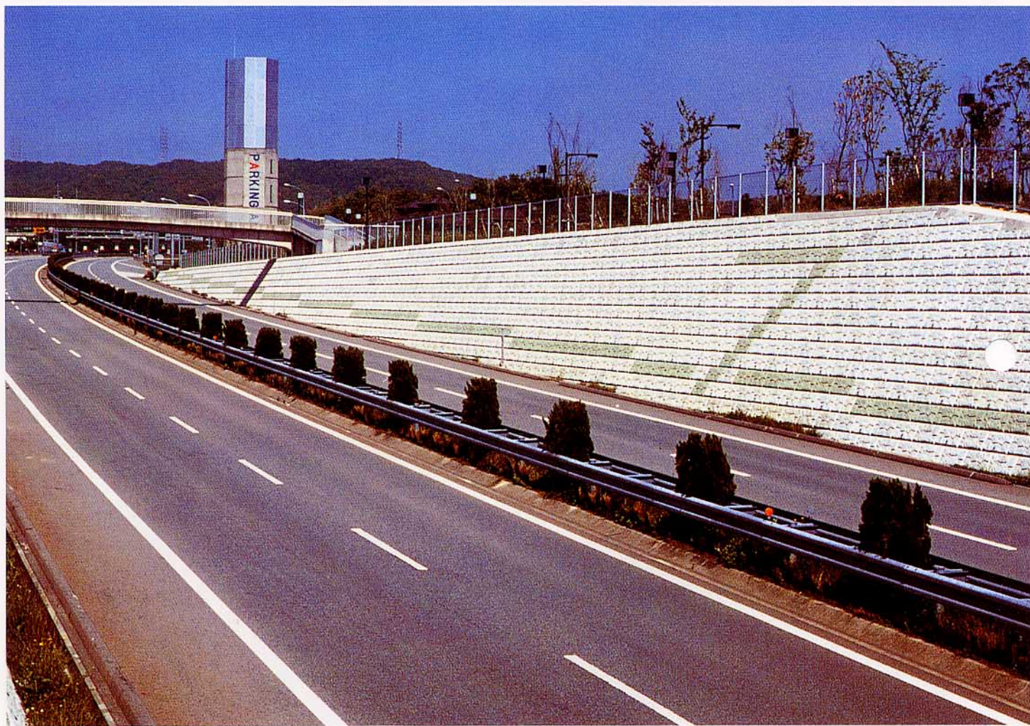
阪神高速北神戸線法面補修工事
