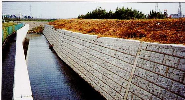
神奈川県 五ヶ村排水路施設工事
