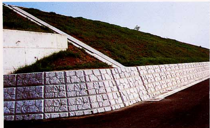
宮城県 仙台東道路工事
