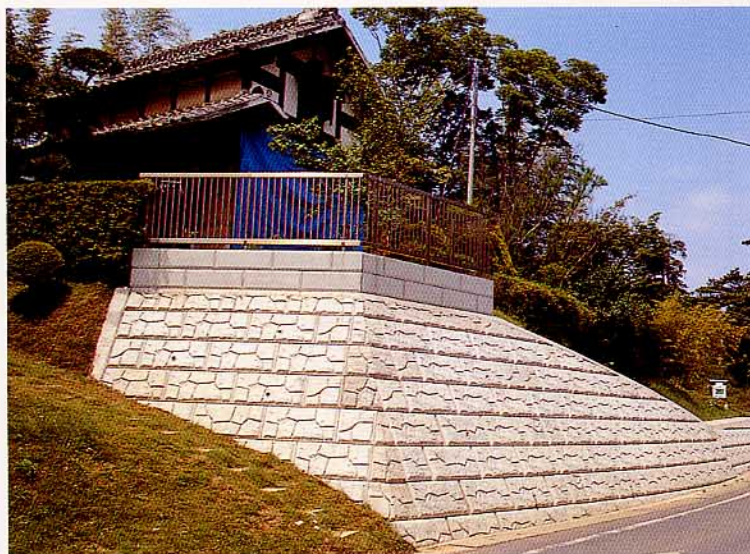
茨城県 県道道路災害防除工事
