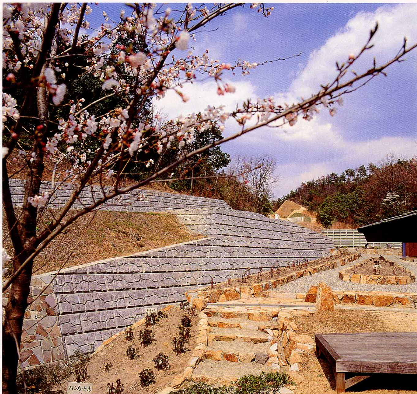
香川県 町道五毛線改良工事
