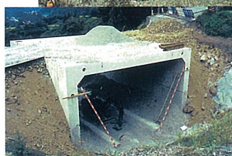
国補火山防災工事・BOX工 (姫川砂防事務所)
