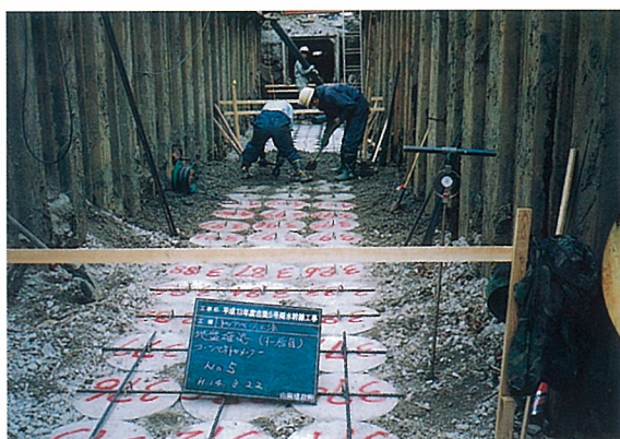
古里5号雨水幹線 (長野市役所)
