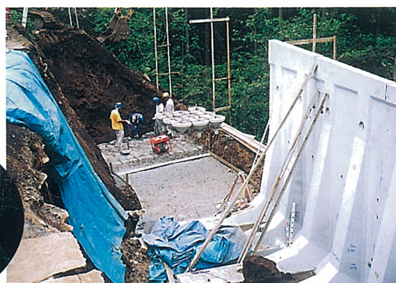
原野地線道路改良 (真田町役場)
