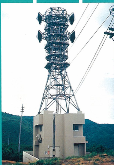
建設省長岡国道工事事務所 小村峠無線中継塔
