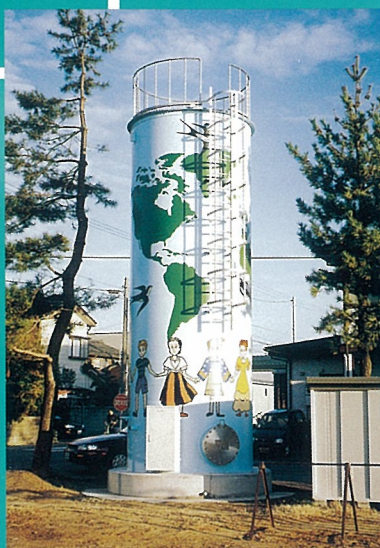
明和工業 セーフティタワー(貯水タンク)
