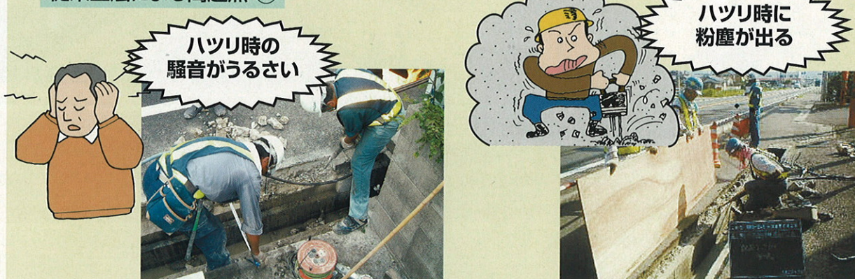
従来工法であるコンクリートブレイカーによるハツリ作業
