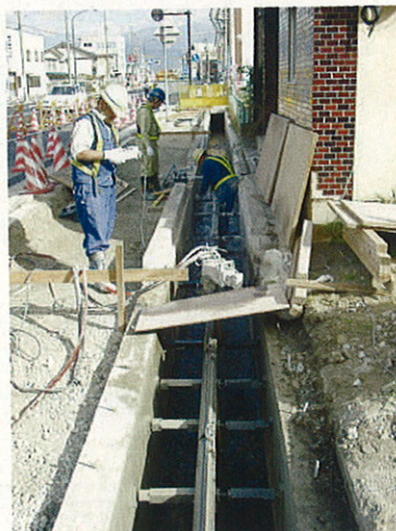
場 所：長野市 施主名：国土交通省 長野国道事務所 工事名：高田環境整備1工事 延 長：220m
