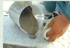
蓋のアンカー筋孔に。
