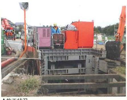
※急曲線施工に対応するため、特殊油圧設備を搭載。
