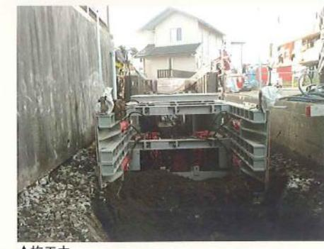
※開削工法の土留め矢板が打込めない狭隘箇所のため、函渠と同じ幅である推進タイプのシールド機を使用して施工。
