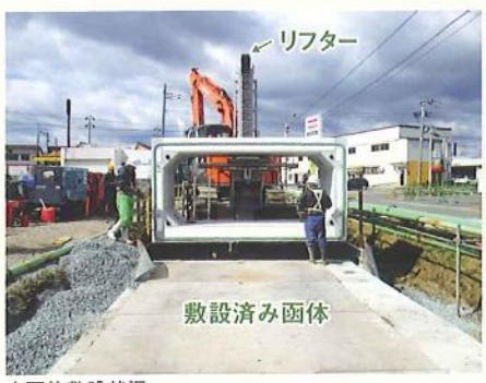
※河川敷地内施工のため、シールド機にバックホウ及び函体据付け用リフターを載置。
