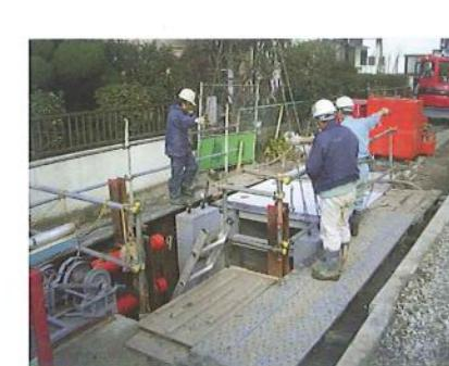
▲函体は発進立坑内に吊り下し、元押し設備で順次送り出します。
