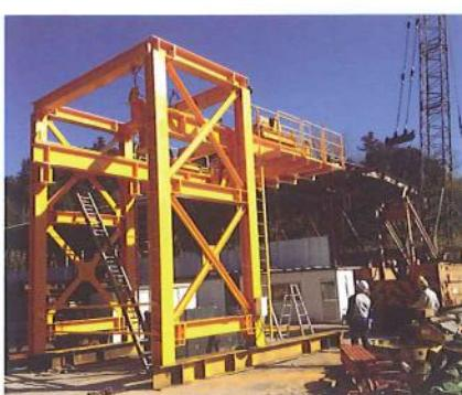
▲クレーンの進入ができない場所では、シールド機に函体吊り下ろし設備を載置
