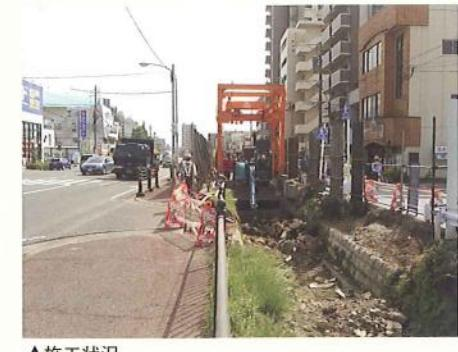
※三面水路敷地内での施工。シールド機にバックホウ、函体吊り下ろし設備を載置して施工。
