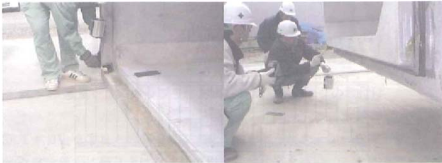
写真－2 滑材塗布状況
