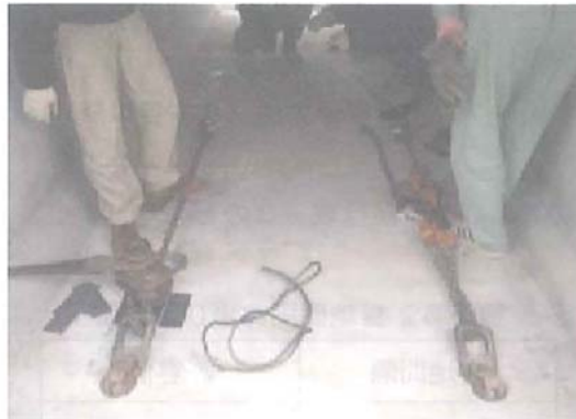
写真-3 カップラーおよびレバーブロックの取付け
