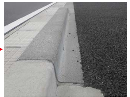
施工から2年経過
