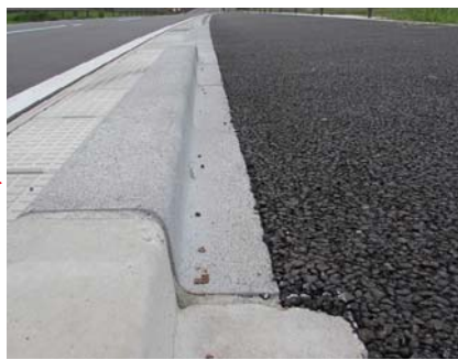
施工から1年経過
