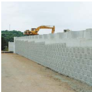
補強土壁 (ジオグリッド)
