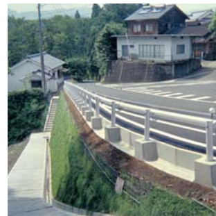
ジオテキスタイル補強土壁
