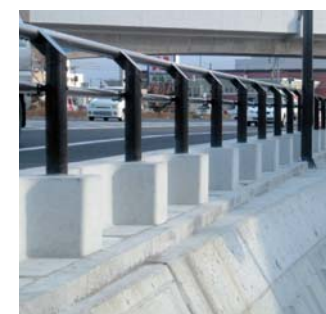
大型ブロック積擁壁
