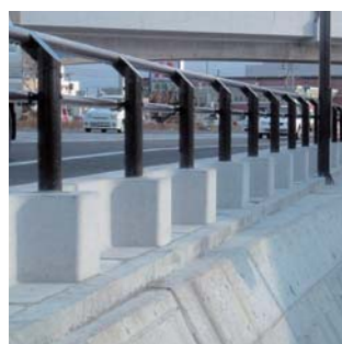
大型ブロック積擁壁
