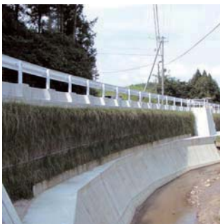
ジオテキスタイル補強土壁
