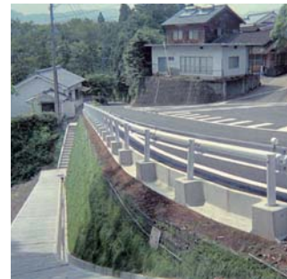
ジオテキスタイル補強土壁
