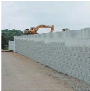
補強土壁 (ジオグリッド)
