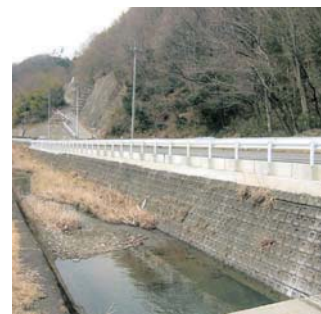
既設ブロック積擁壁
