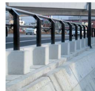
大型ブロック積擁壁
