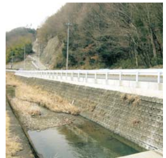
既設ブロック積擁壁
