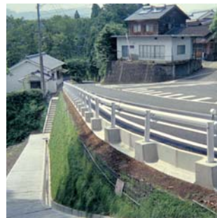
ジオテキスタイル補強土壁
