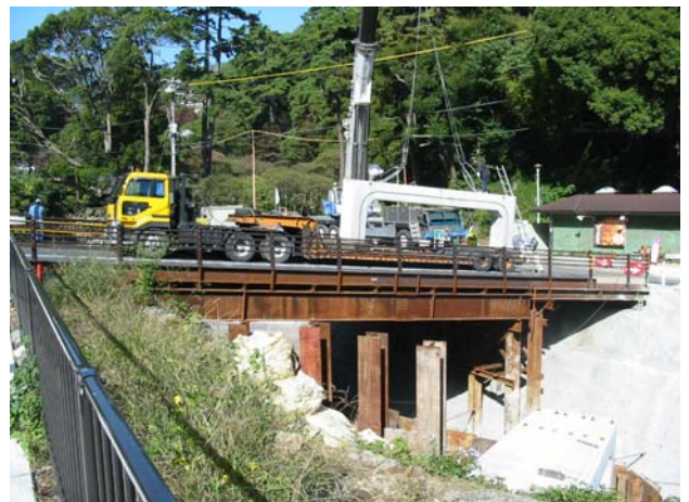
上部ブロック 吊り金具セット完了
