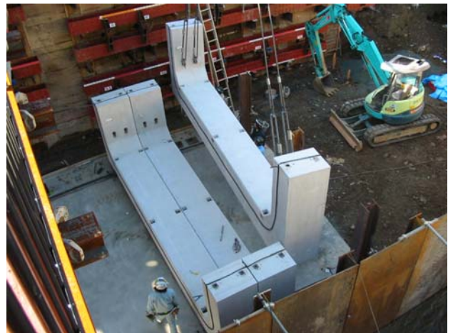
下部ブロック据付
