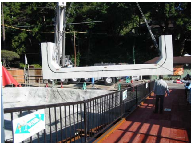
下部ブロック吊り降し
