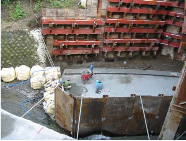
基礎打設 (溝形鋼設置)
