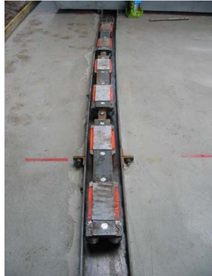
チルタンク設置
