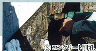
③ コンクリート削孔
