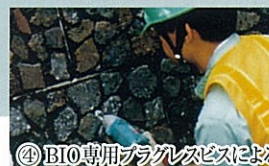
④ BIO専用プラグレスビスによる固定
