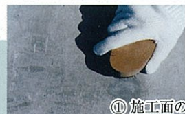
① 施工面の準備
