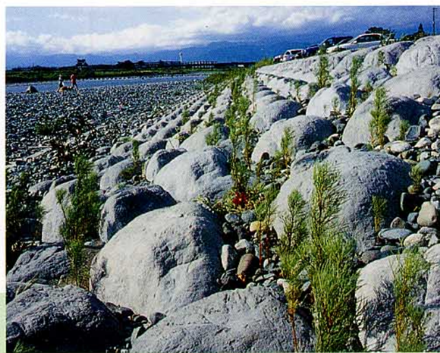
神奈川県 酒匂川中小河川改修工事
