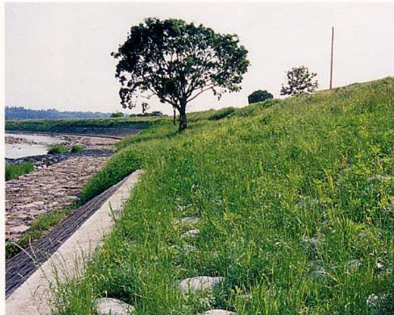
熊本県 村田根固災害および関連工事(施工後2ヶ月)
