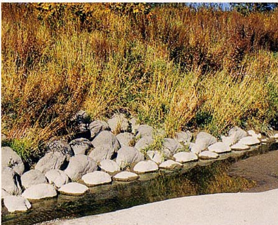
北海道 戸蔭別川道単改修工事
