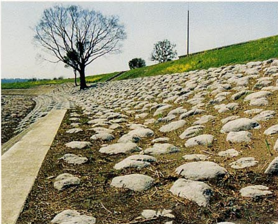
熊本県 村田根固災害および関連工事(施工直後)
