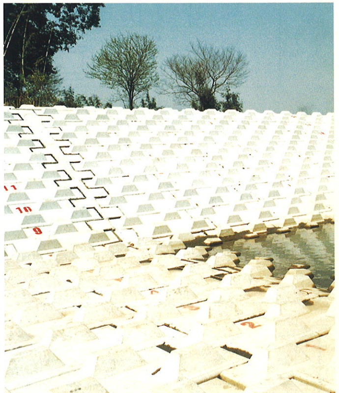
埼玉県川澄護岸災害復旧工事
