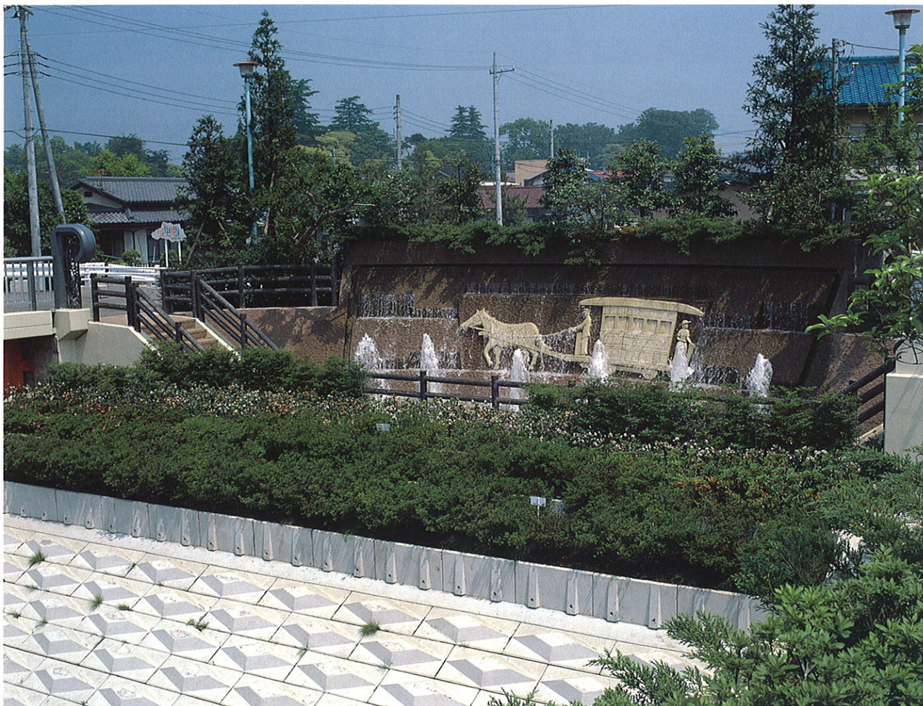
埼玉県大落古利根川改修工事
