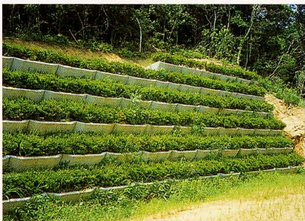
三重県 大仏山公園県単公園環境整備工事
