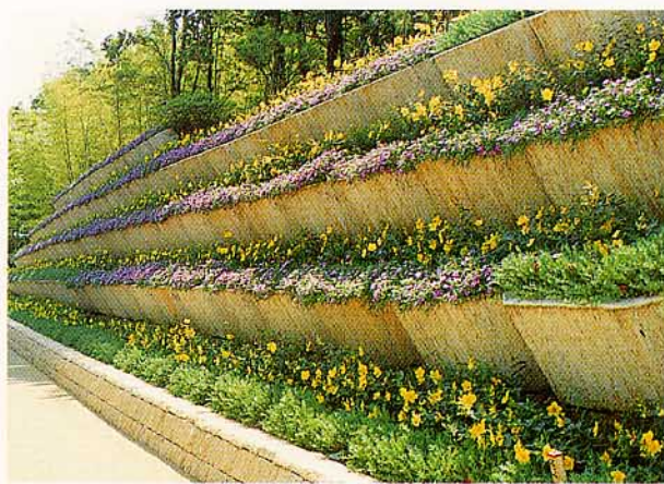
石川県 木場潟中央公園地整備工事
