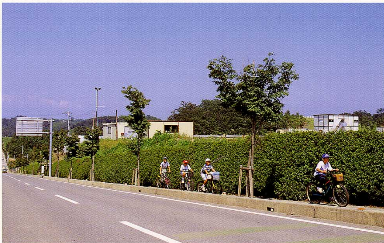
群馬県 もみじ平総合公園工事
