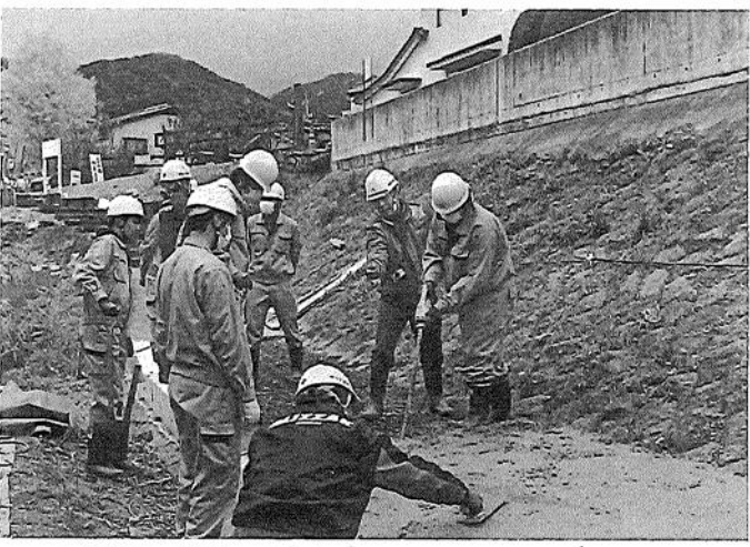
原山社長の指導を受けながらコンクリート打設を行う3年生
